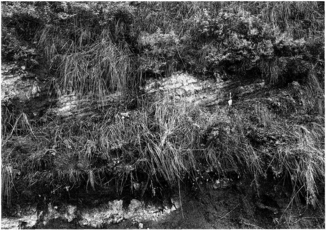
2. 西山城址北墙夯层 (19号)
